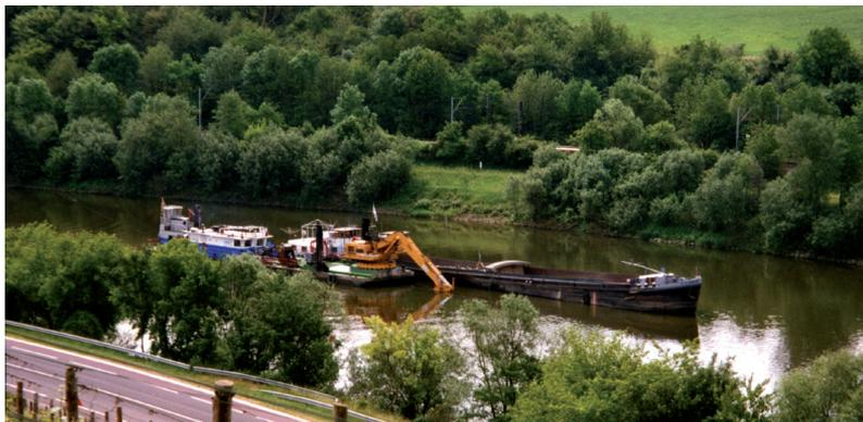
*Chantier de dragage avec pelle hydraulique montée sur ponton à béquilles en action*
