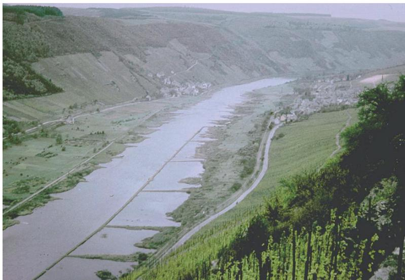
Mesure type d'aménagement avec digue longitudinale et épis transversaux
